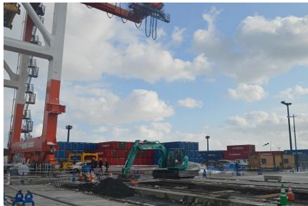
岸壁工事の様子
